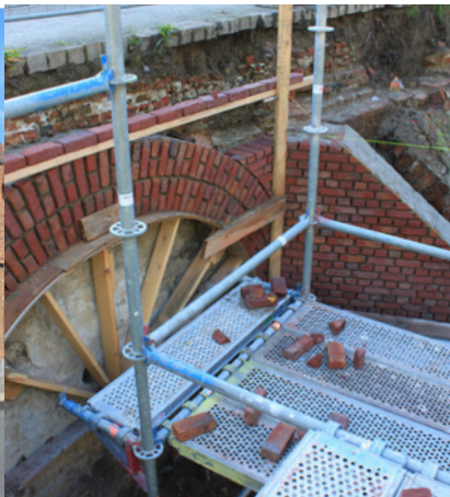
Restauratie tunnelmond en tunnelmuur (met zicht op straatzijde paardenstal), foto HVR
