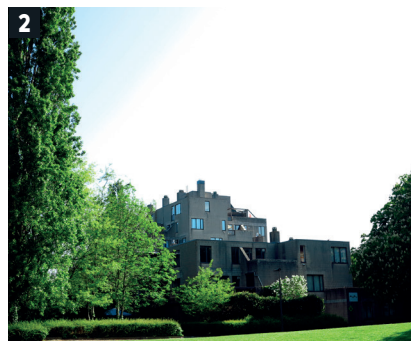
1 Sociale woningen getekend door de bekende architect Renaat Braem. 2 Woontorens op de immense Arenaweide.
