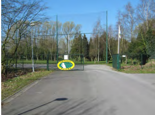
Bij de ingang (afsluitbare poort)
