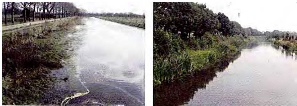
Figuur 14: Geesterstroomkanaal links in 1988 net na de aanleg van de plasberm en in 1989 rechts
