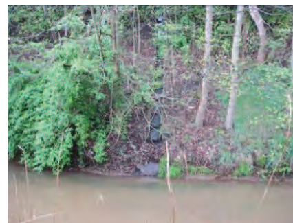
Foto 13: afwatering van de N71
