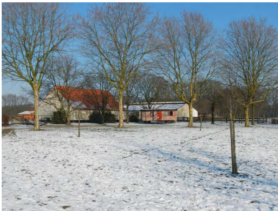
Figuur 49 Private woning en bijgebouw in het noordoosten
