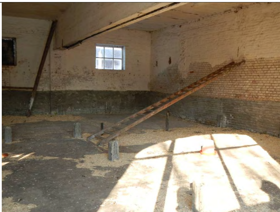
Figuur 48 Binnenruimte noordelijke vleugel van de Landlopersboerderij
