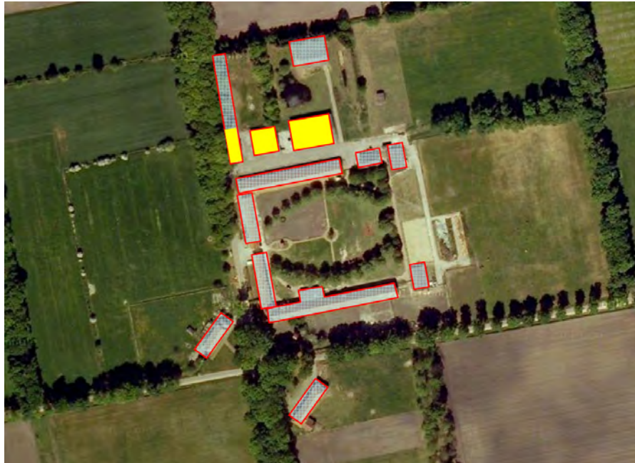
Figuur 62 Gebouwen in gebruik door de stad Hoogstraten
