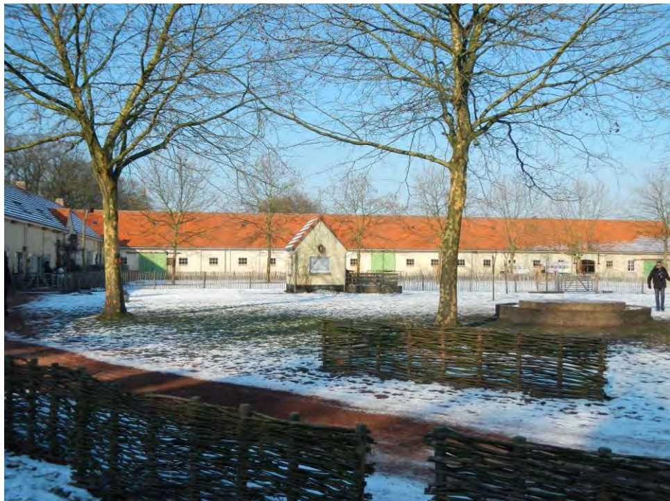
Figuur 47 Noordelijke vleugel van de Landlopersboerderij
