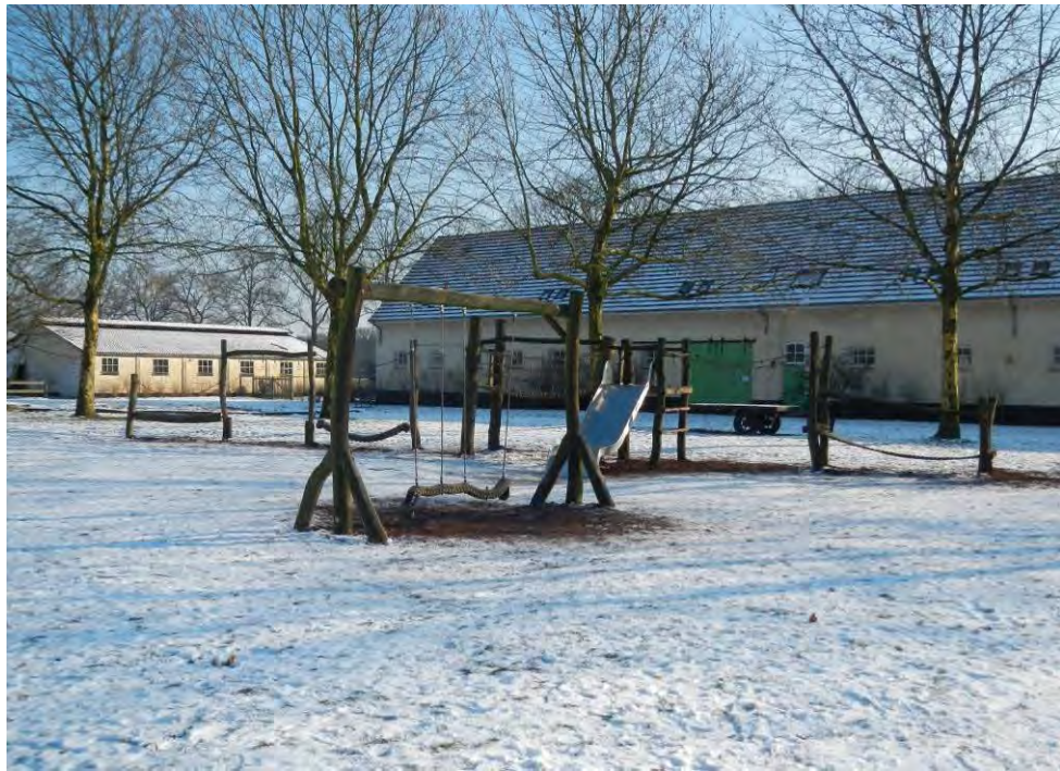
Figuur 50 Zuidelijke vleugel met bijgebouw van de Landlopersboerderij
