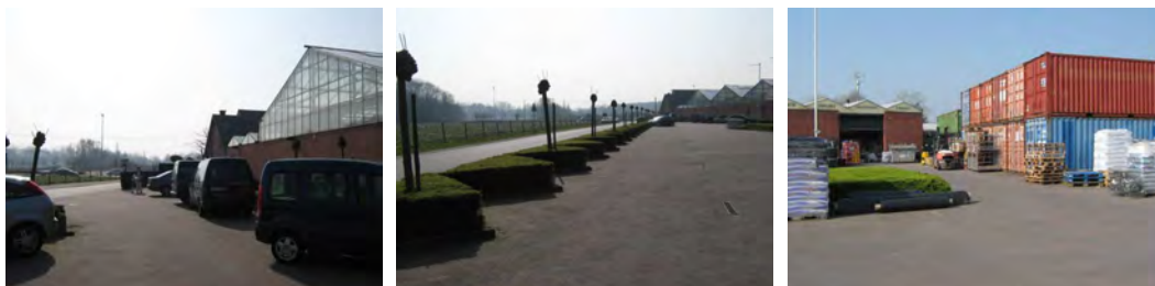
Foto 14 / 15 / 16: Parkings en zone stapelen/laden/lossen Rijmenants t.h.v. Osseweg
