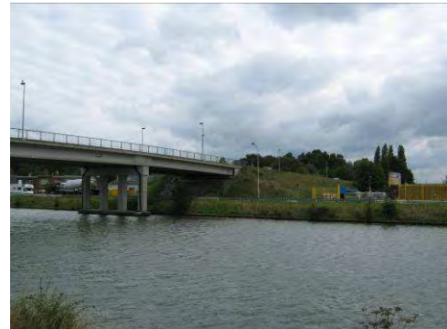
Viaduct van de Berlaarsesteenweg
