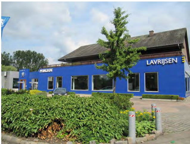
F5 : bestaande garage + woningen
