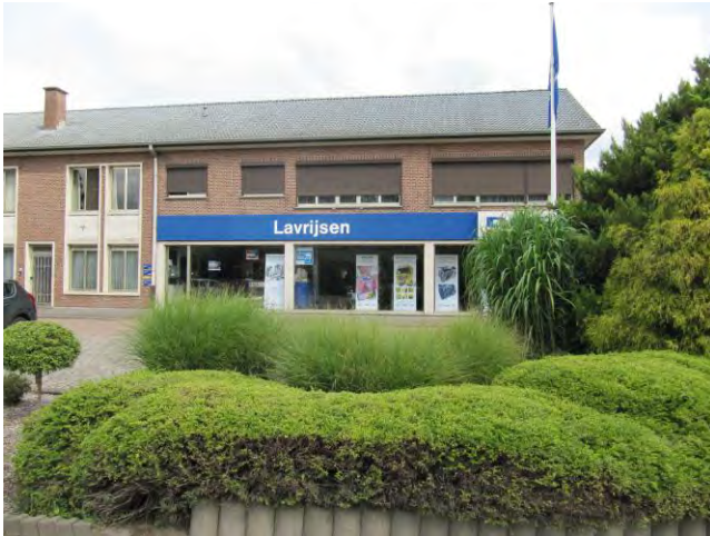
F3 : bestaande garage + woningen
