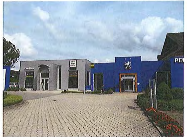
F6 : bestaande garage
