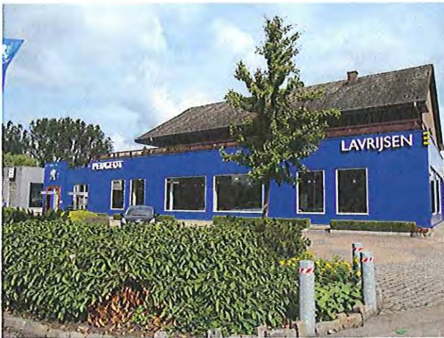
F5 : bestaande garage + woningen
