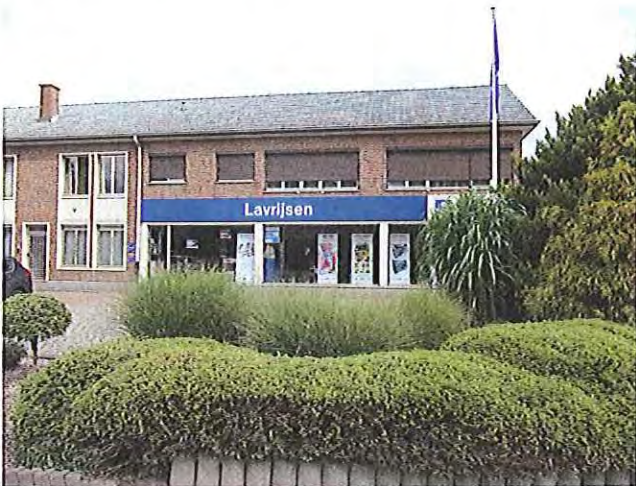
F3 : bestaande garage + woningen
