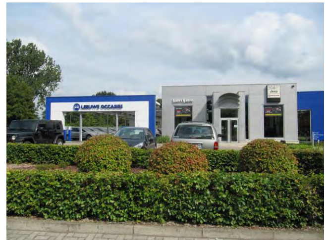
F6 : bestaande garage
