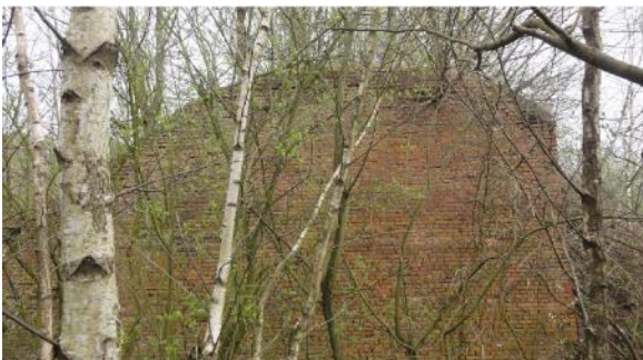
Restanten bouwwerk (R08)
