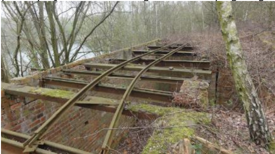
Relict met spoorlijn (R01)
