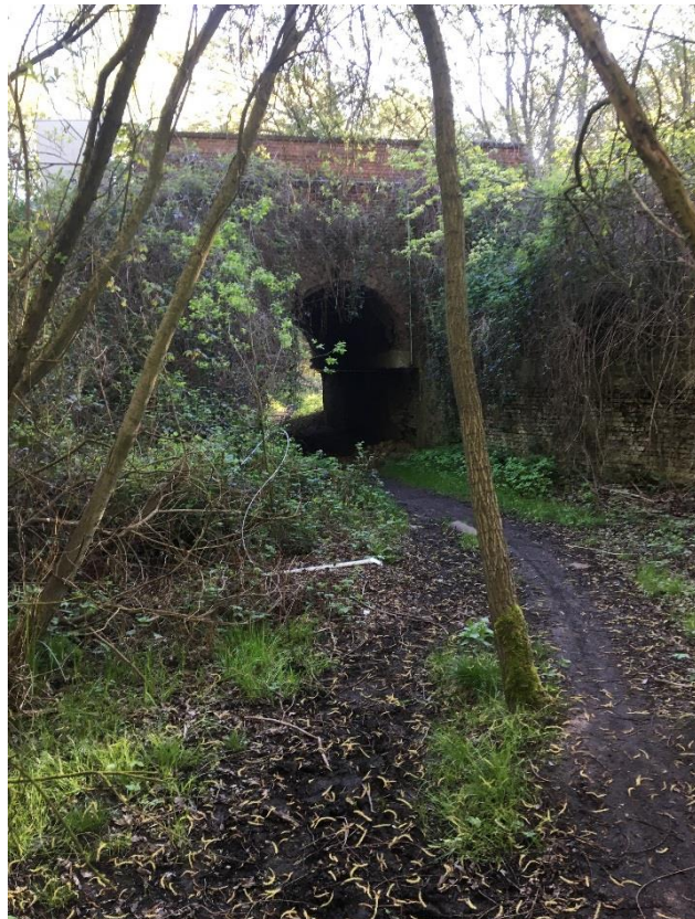
Bestaande situatie ter hoogte van corridor Molleveld met zicht op de bestaande tunnel onder de Kapelstraat
