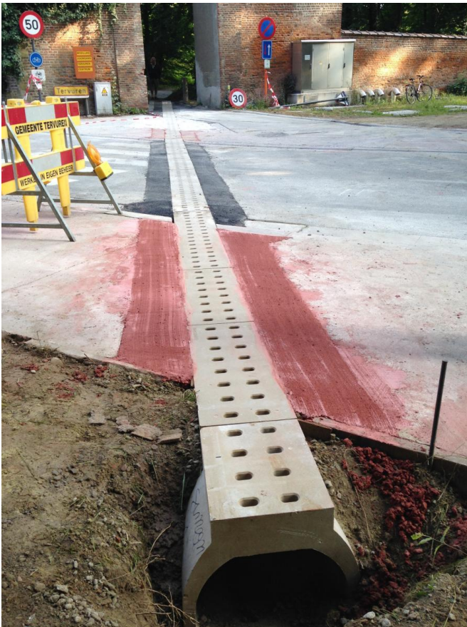
Figuur 8.16. Voorbeeld van een amfibieëntunnel (bron: wegen en natuur).
