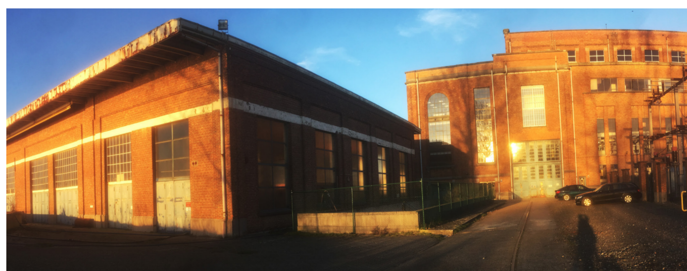
Het pompgebouw en de generatorhal in de ondergaande zon
