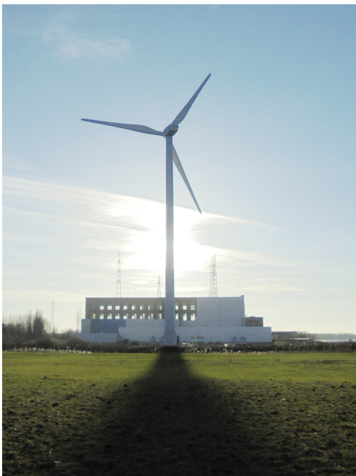
De windmolen torent hoog uit boven de generatorhal en de aangebouwde magazijnen
