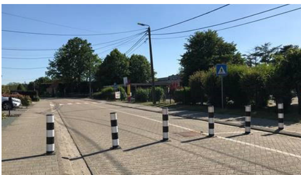
De paaltjes staan over de hele breedte van het profiel. De paaltjes op de voetpaden zijn er later bijgeplaatst omdat voertuigen over het voetpad en de berm reden © Olen
