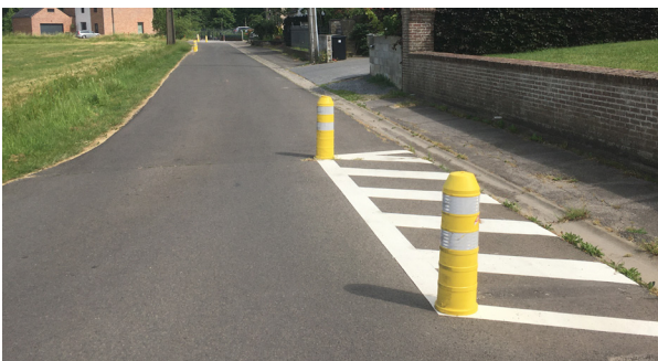
Kleine, tijdelijke aanpassingen vestigen de aandacht op een zijstraat en remmen de snelheid. © TRIDÉE
