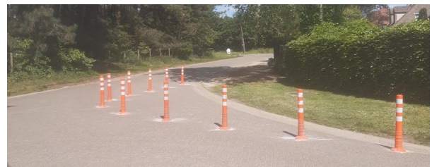
Lille gebruikt in een rustige straat tijdelijke paaltjes om het effect te testen van een krappere bocht. Voorzie eventueel extra markering zodat de paaltjes goed opvallen. © Lille
