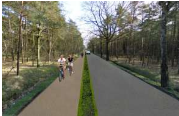
Collage met mogelijke herinrichting N153 tussen Wechelderzande en Malle: versmallen rijweg en aanleg dubbelrichtingsfietspad
