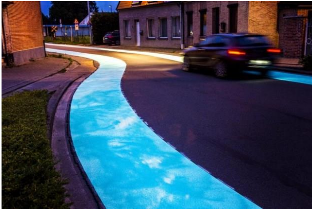
Figuur 23: Fietssuggestiestroken met een reflecterende coating in Dendermonde
