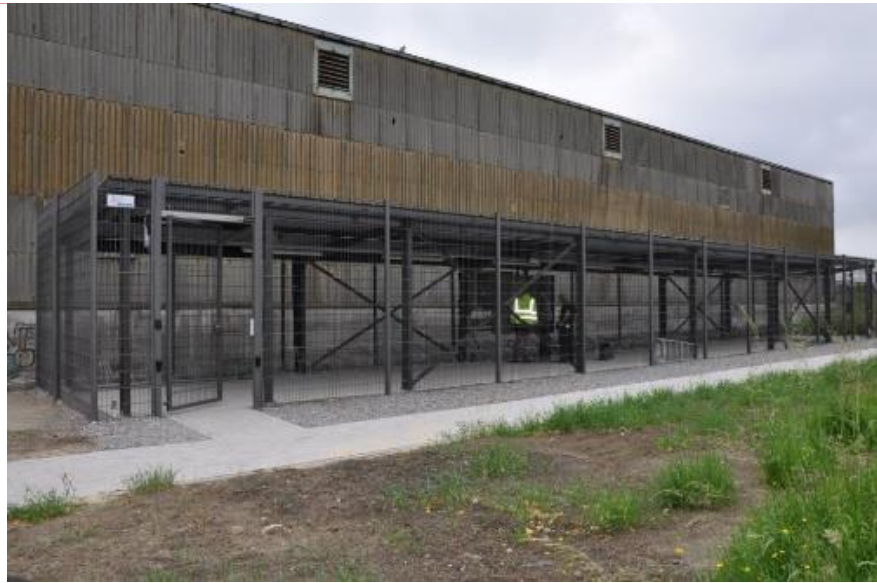
Figuur 40: Beveiligde fietsenstalling Umicore Hoboken
