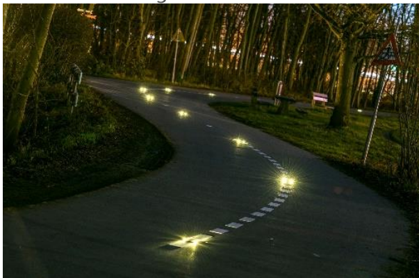
Figuur 22: LED-panelen geïntegreerd in het wegdek
