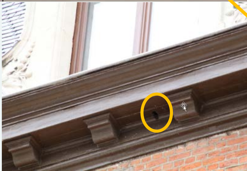
Dakgoot na renovatie 2018
