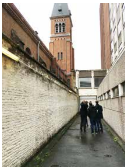
links: aan te kopen volume van de kerk centraal: (te) smalle strook naast het gebouw
