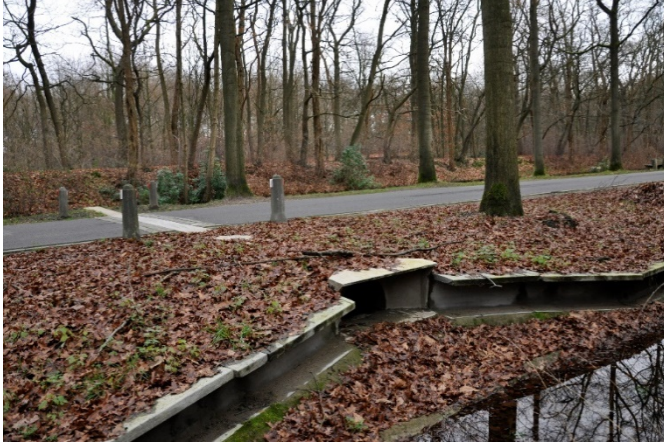
Amfibieëntunnel aan Kerkedreef te Brasschaat © Kristin Van Laer
