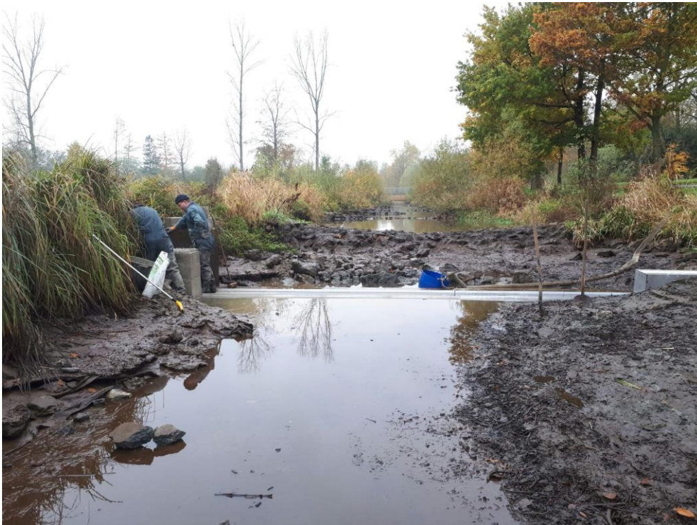
Figuur 5: Man at work. In een tijdelijk drooggelegde vistrap worden de eerste funderingen voor de krabbenval gebouwd.
