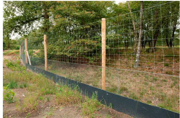
Amfibieënscherm en raster voor kleine respectievelijk grote dieren (MJPO, 2013. Leidraad faunavoorzieningen bij infrastructuur Bijlagen)
