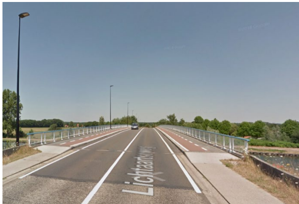
Huidige situatie Olen – brug Lichteartseweg (©Google Street View™ mapping service)
