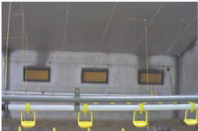
Foto 6: transportgrepen kunnen leiden tot condensvorming op de panelen.
