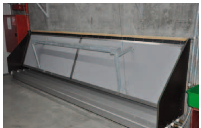
Twin-verwarmingsbuizen onder de regelbare luchtinlaatklep
