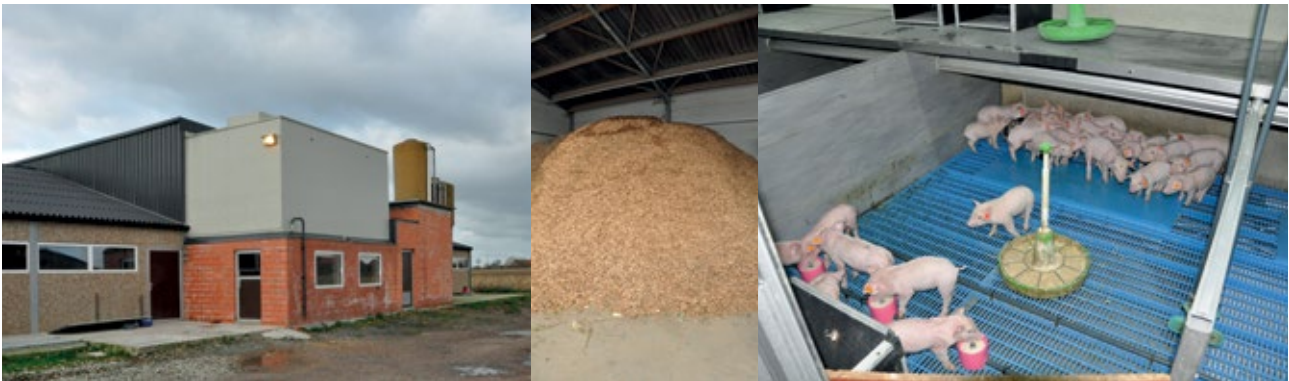
Afbeelding 14. Van links naar rechts: stooklokaal met daarboven de luchtwasser; opslagruimte in bestaande hangar voor droge houtsnippers; biggenbatterij
