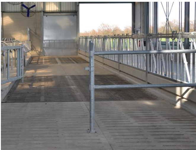
Fig.1: schematische voorstelling van het deel van de stal met 3 ammoniakemissiereducerende vloeren
