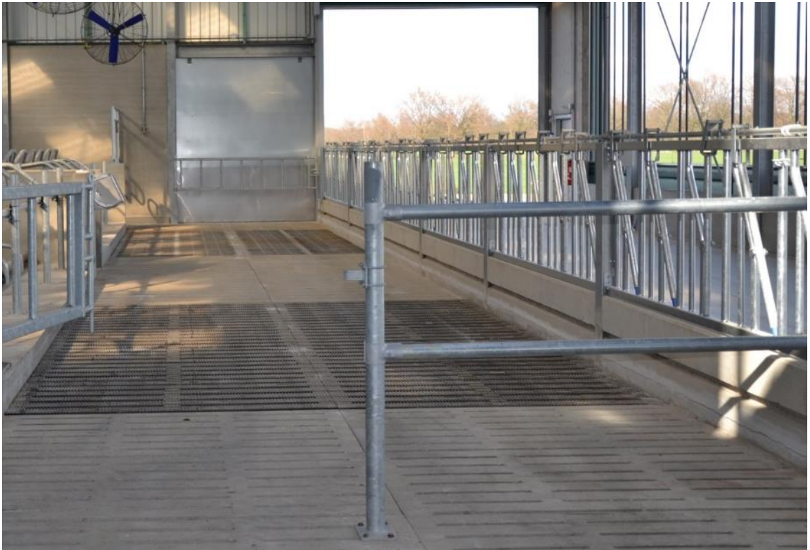
Figuur 1: AEA-vloeren in de melkveestal van Hooibeekhoeve
