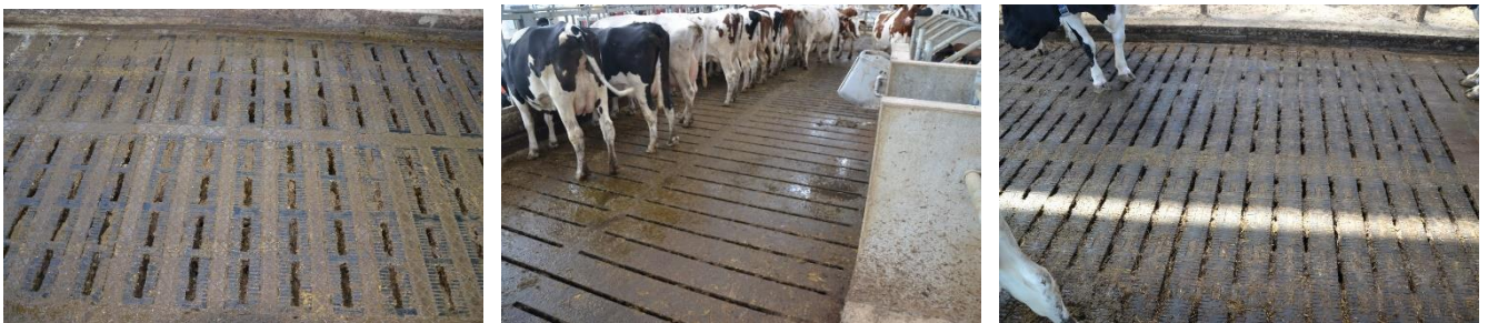
Figuur 2: Emissiearme vloeren op Hooibeekhoeve, van links naar rechts: Eco-vloer, G3 en Meadow.
